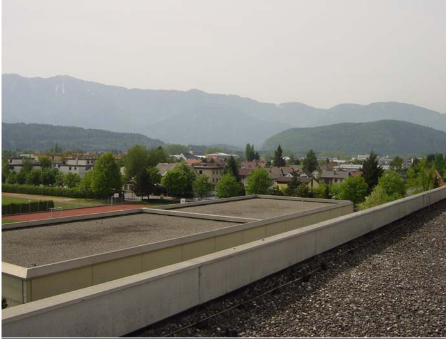
Abbildung 6-1: Flachdachsanierung der HTL-Villach [Werner, 2003]
